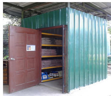
Gambar 7: Stor tempat penyimpanan khas bagi bahan kimia/racun perlu mempunyai pengudaraan yang baik dan tidak terdedah kepada cahaya matahari. Sumber : JPBW
